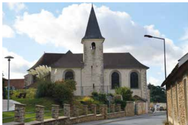
L'église du Saint-Rédempteur a été construite entre 1722 et 1726. Elle a fait l'objet d'une restauration entre 1976 et 1981. Sa charpente doit être rénovée cette année par la Ville de Fleury-Mérogis.
