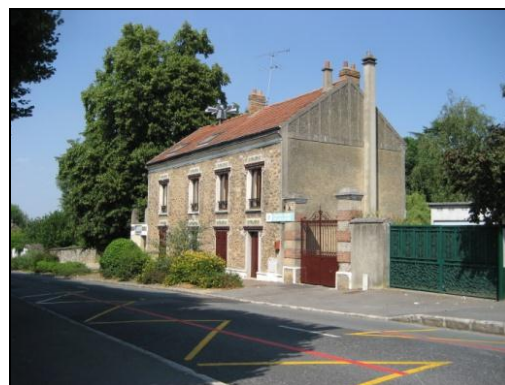
Bâtiment en meulière avec mosaïques rue Roger Clavier
