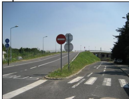
Le pont au-dessus de la Francilienne
