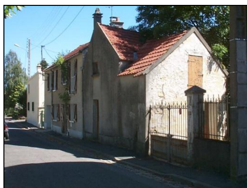
Alignement rue Jean-Marillier
