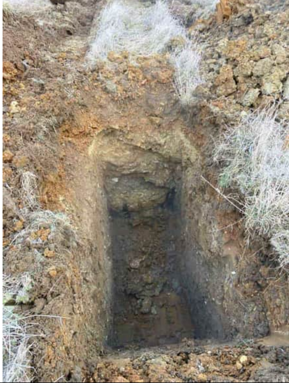
Fond de fouille
