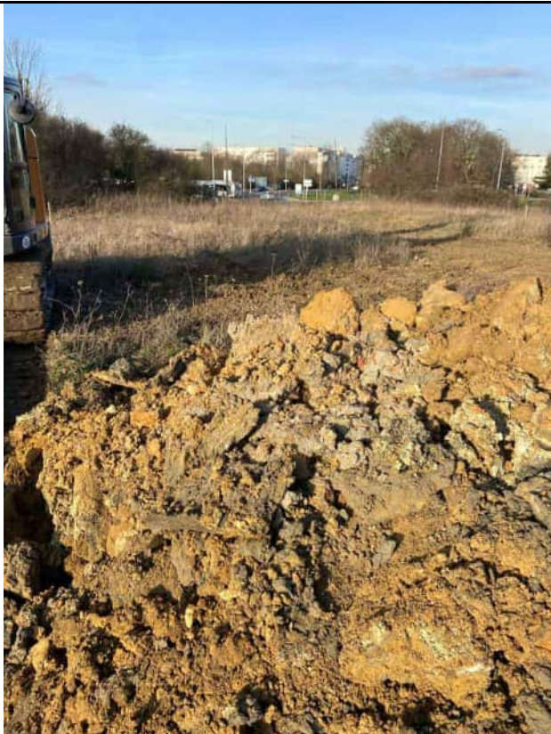
Profondeur de 2 à 3 m
