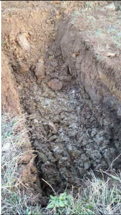
Fond de fouille
