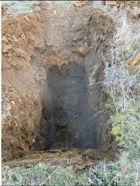
Fond de fouille
