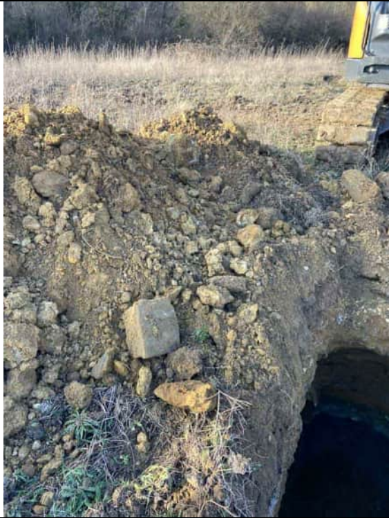
Profondeur de 0 à 1 m
