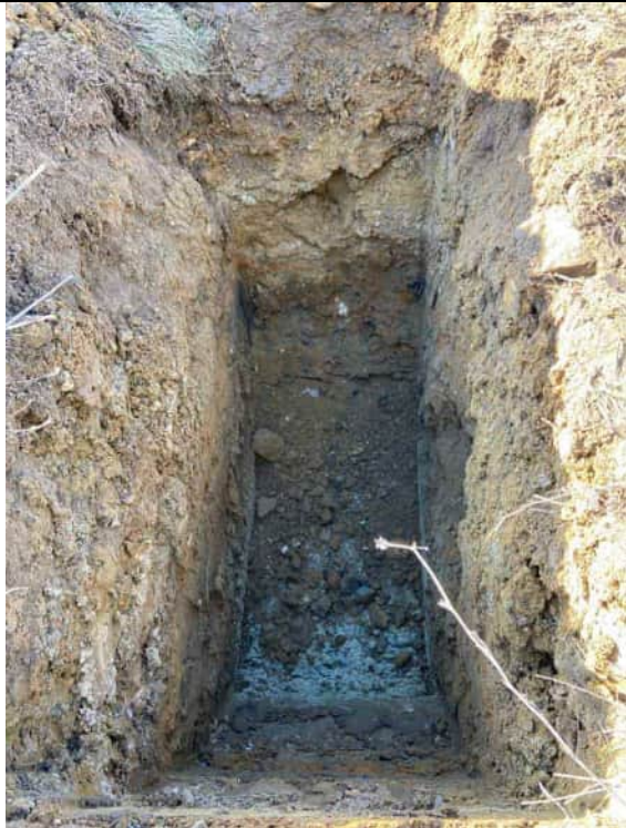
Fond de fouille
