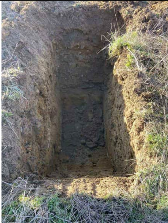
Fond de fouille
