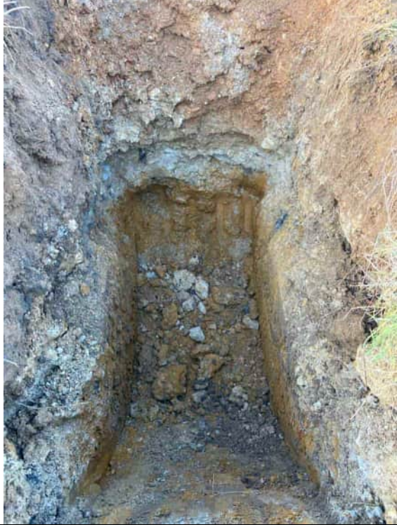
Fond de fouille
