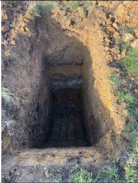
Fond de fouille
