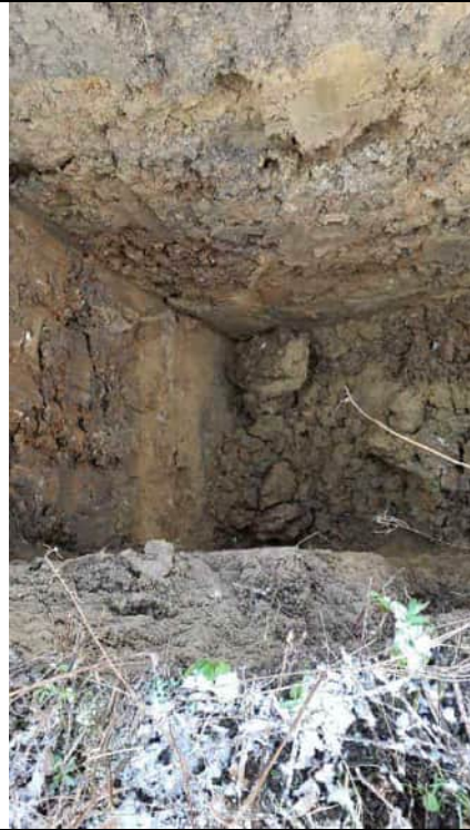
Profondeur de 1 à 2 m
