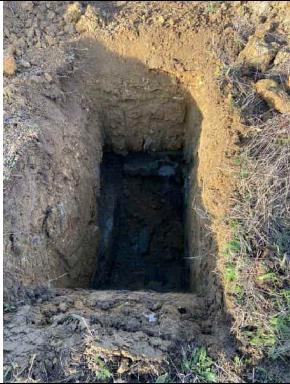
Fond de fouille
