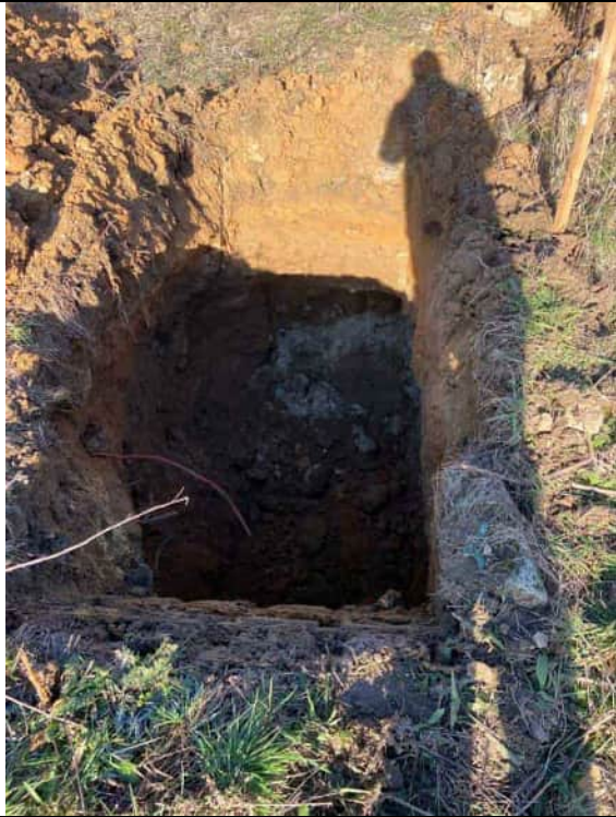
Fond de fouille
