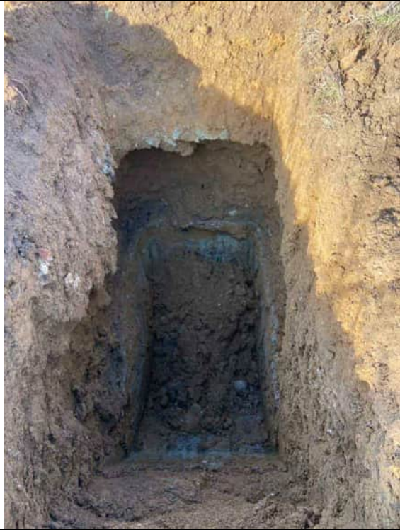
Fond de fouille
