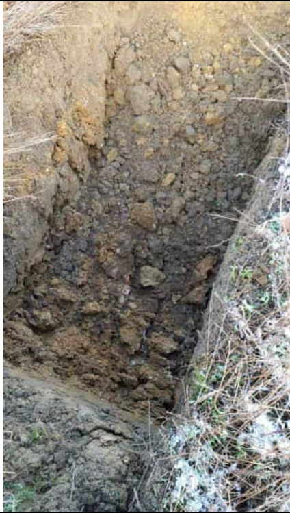
Fond de fouille
