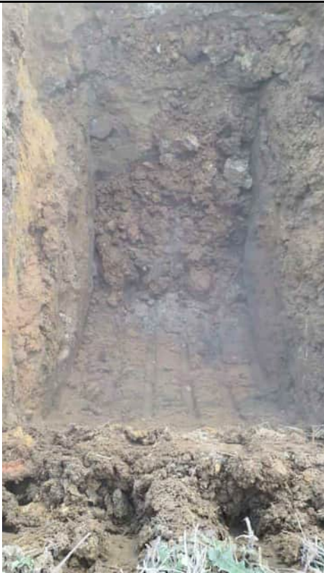
Fond de fouille
