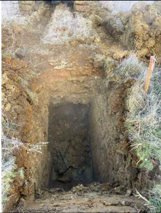
Fond de fouille
