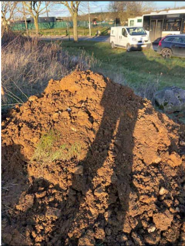
Profondeur de 1 à 1.6 m
